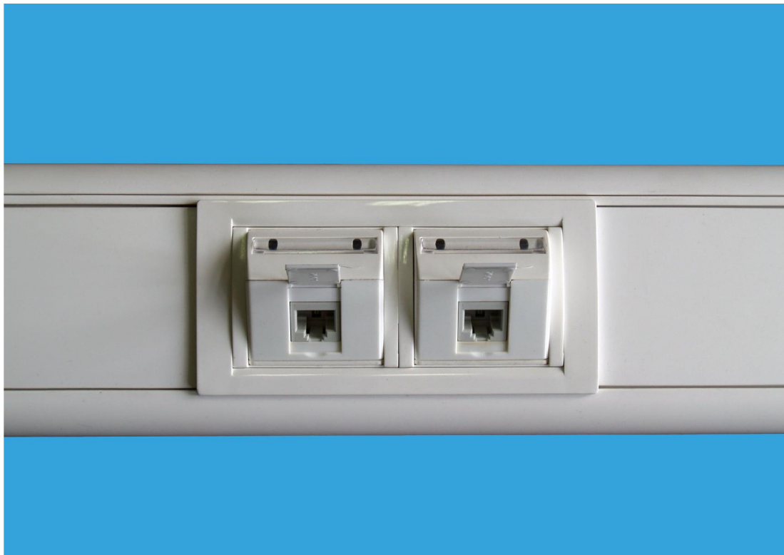
Рисунок 7.9 – Установлення розетки на короб
