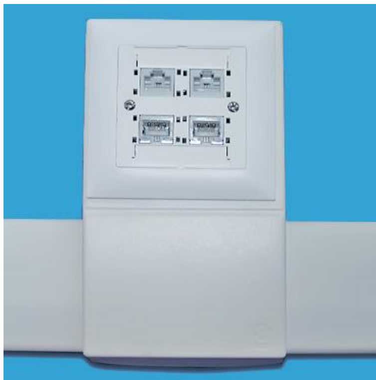
Рисунок 7.10 – Установка розетки поруч із коробом
