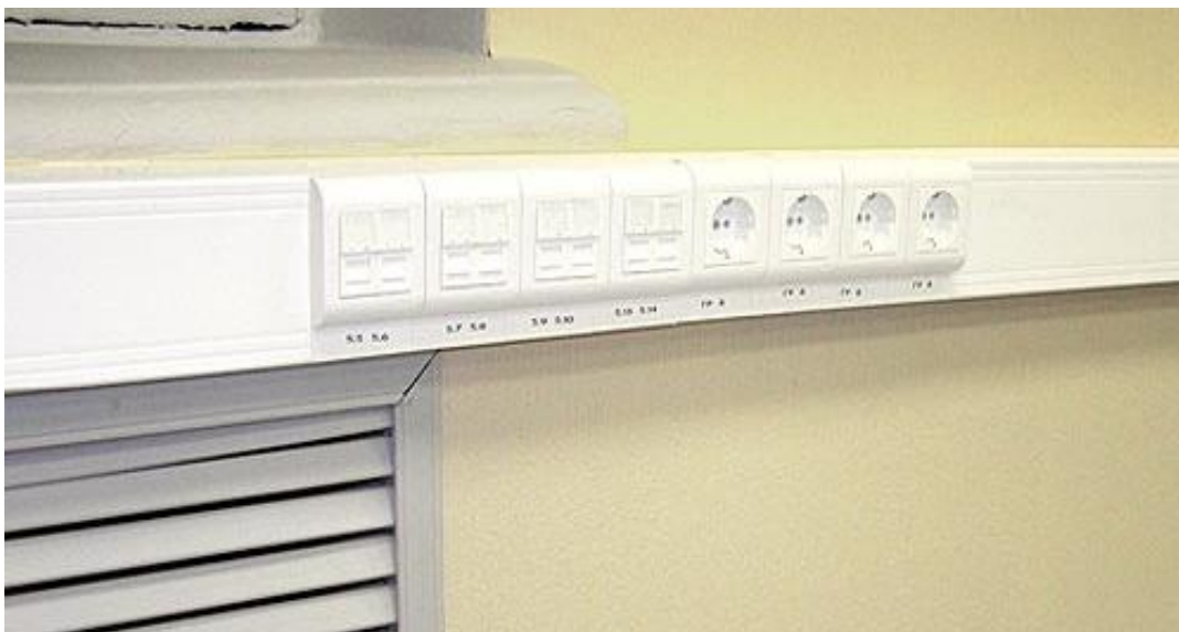
Рисунок 7.11 – Установлення розеток блоком
