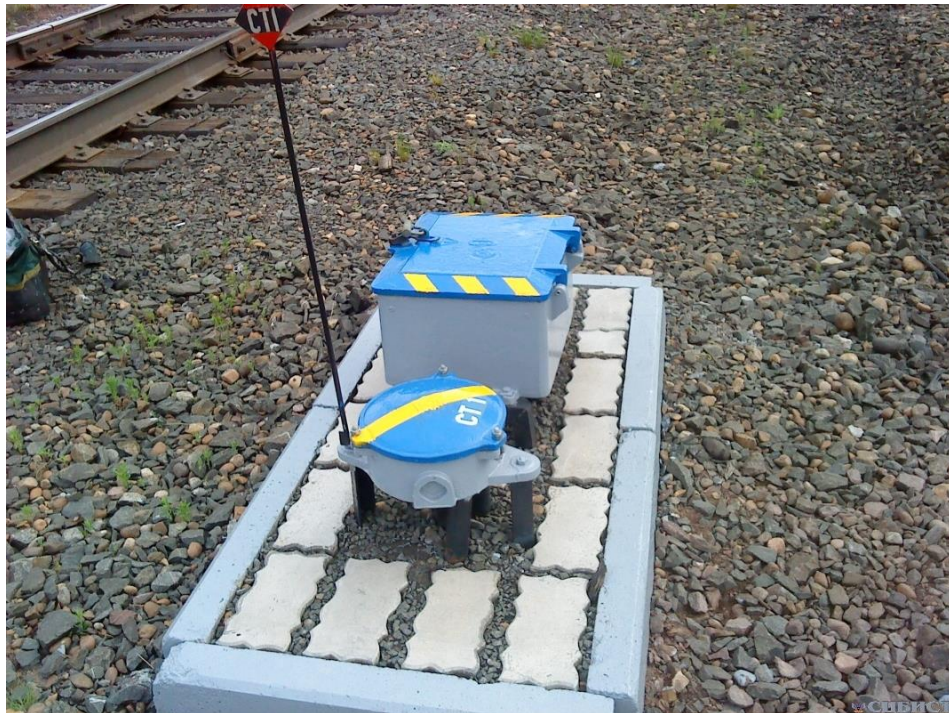
Рисунок 1 – Муфта РМ та ящик трансформаторний ТЯ КМ Стрілочних ЕП
