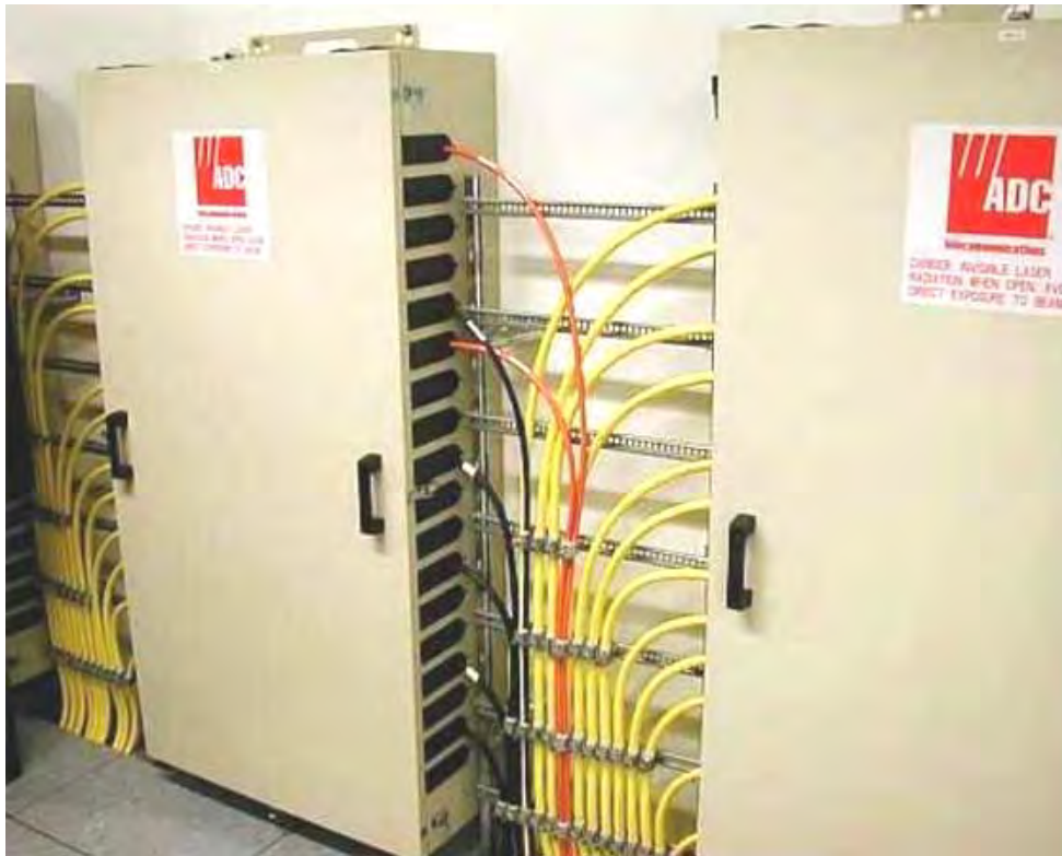
Рисунок 10.15 – Шафа оптична розподільна FEC-864
