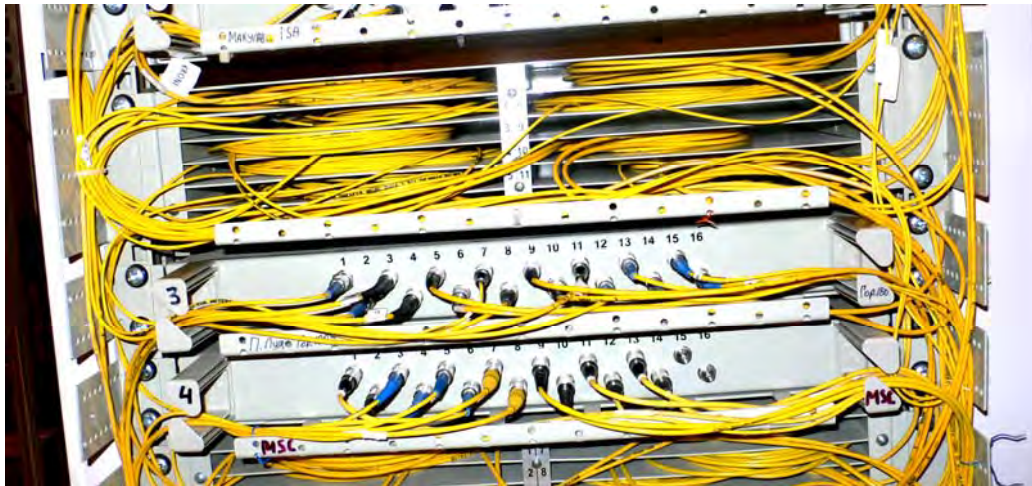
Рисунок 10.14 – Розподільчий пристрій стійкового типу
