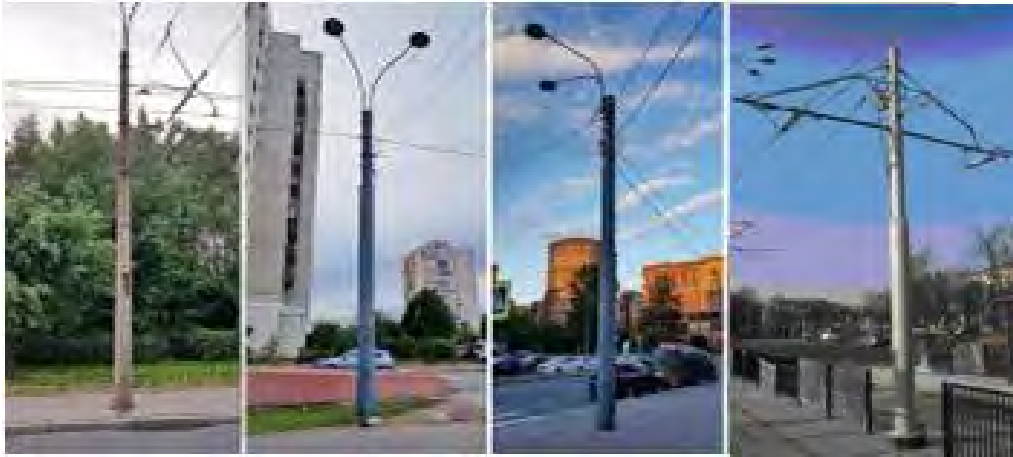
Рисунок 6.2 – Опори контактної мережі тролейбуса
