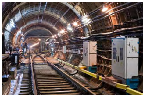
Рисунок 4.7 – Ділянка тягової мережі метрополітену
