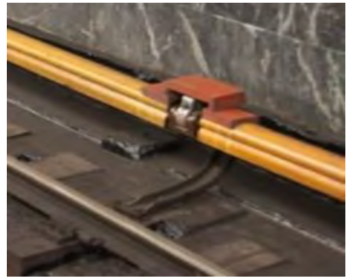
Рисунок 6.18 – Контактна рейка і основні елементи:
