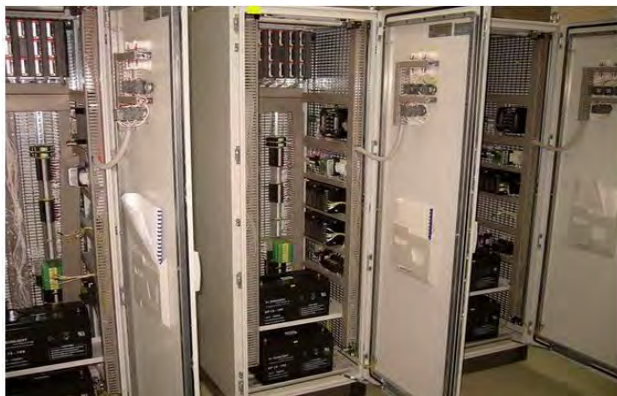
Рисунок 8.5 – Шафа телемеханіки центрального диспетчерського пункту
