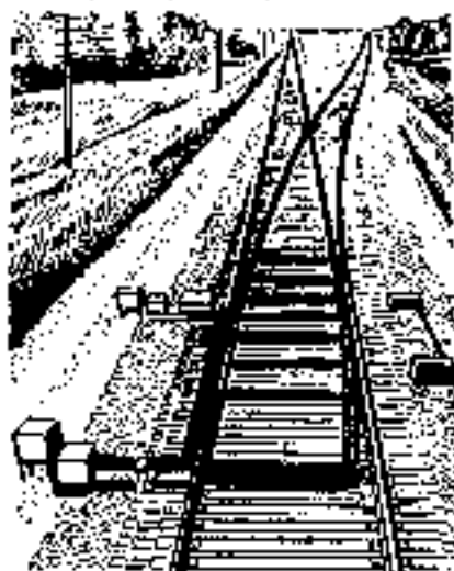
Рис. 2.111. Стрілочний перевод типу Р65 марки \frac{1}{22}
