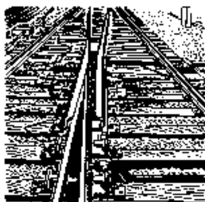
Рис. 2.112. Хрестовина з рухомих сердечником
